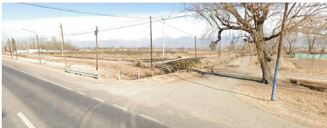
Figura 86: Vista acceso desde Ruta 40
