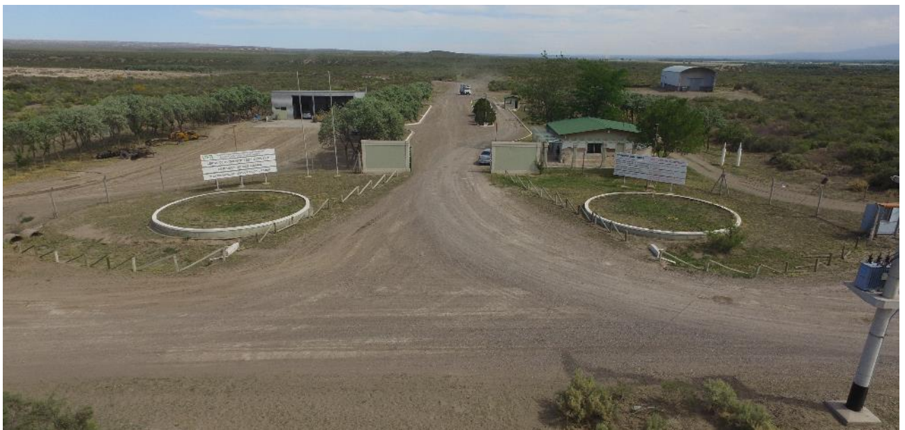
Figura 78: Vista aérea del acceso al CA-COINCE CÁPIZ
