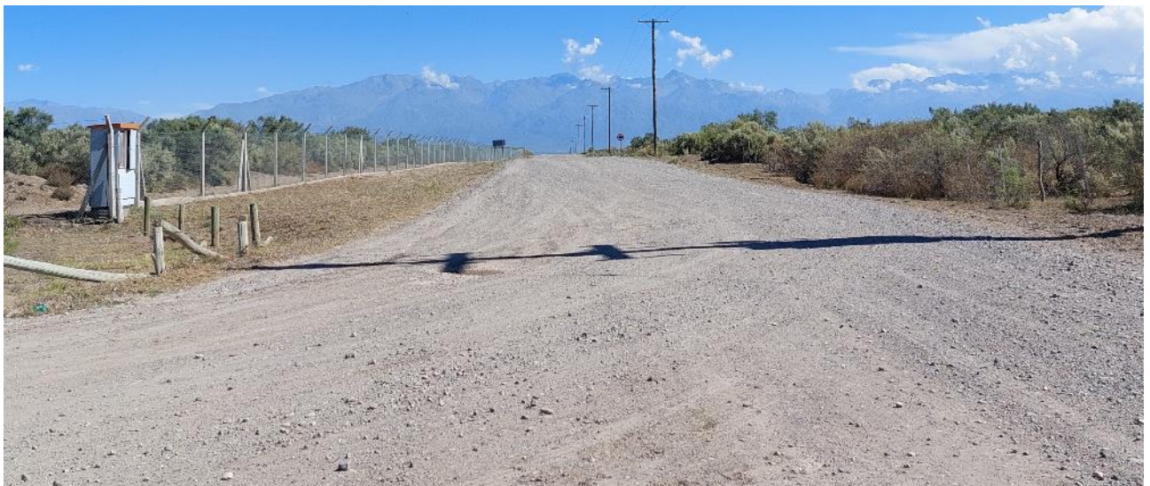
Figura 2: Vista general camino de acceso
