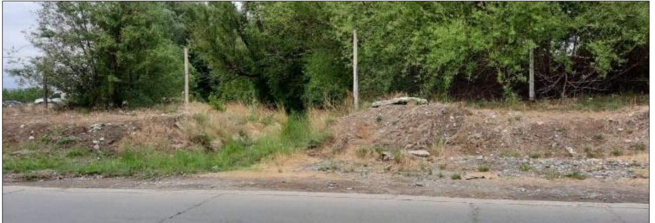
Figura 59: Canal que atraviesa el predio del CA
