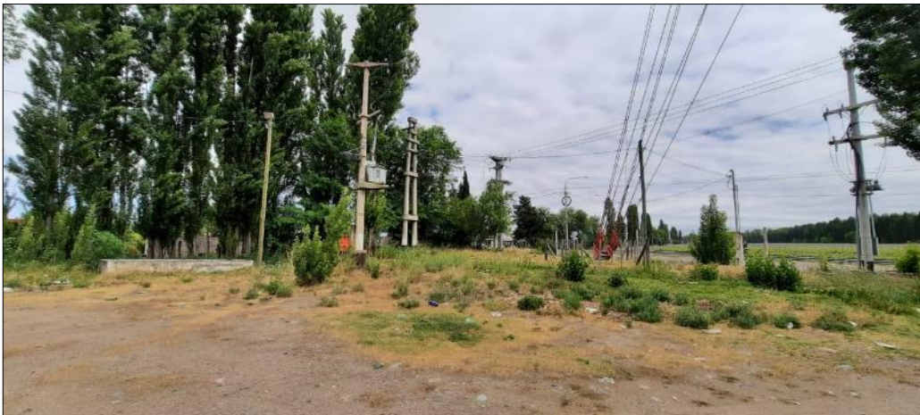
Figura 54: Tillas de anclaje y riendas de antena
