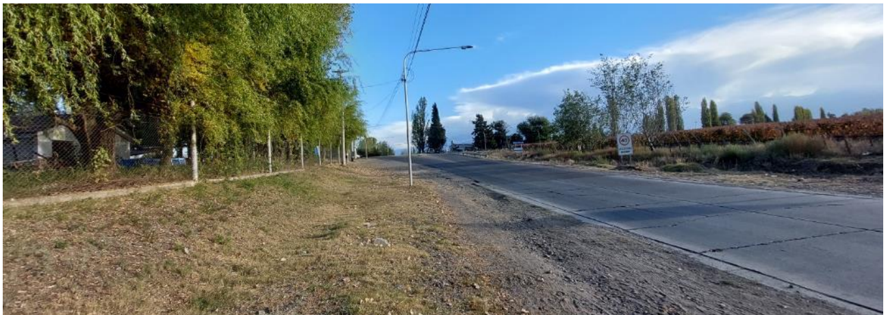
Figura 83: Vista acceso por RP-89
