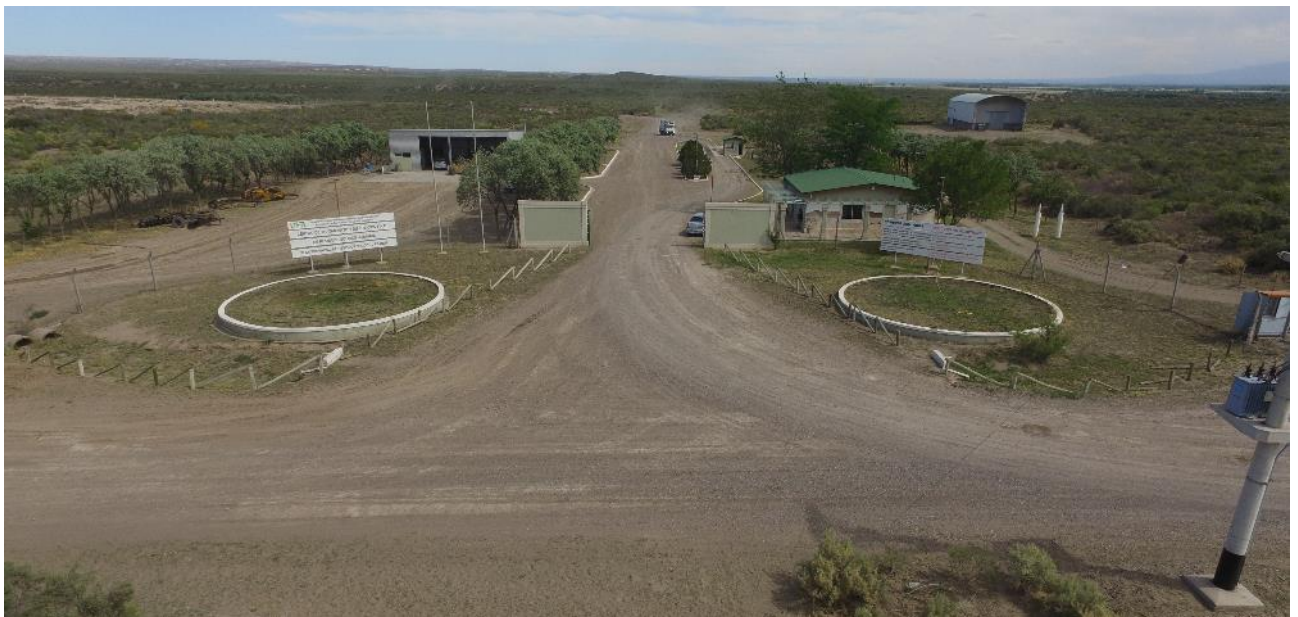
Figura 4: Vista área del acceso al CA-COINCE CÁPIZ
