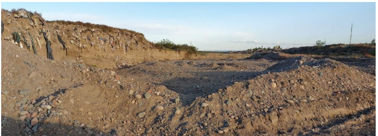
Figura 95: Vista del cauce
