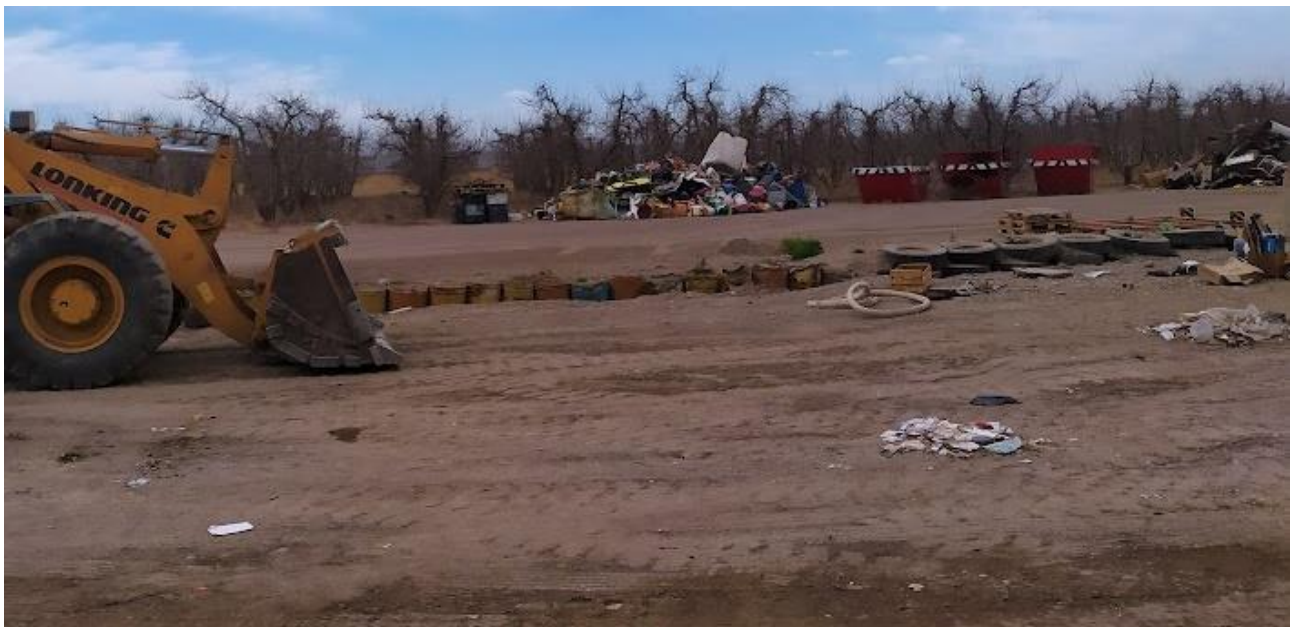
Figura 80: Vista general del predio CAVU-SC
