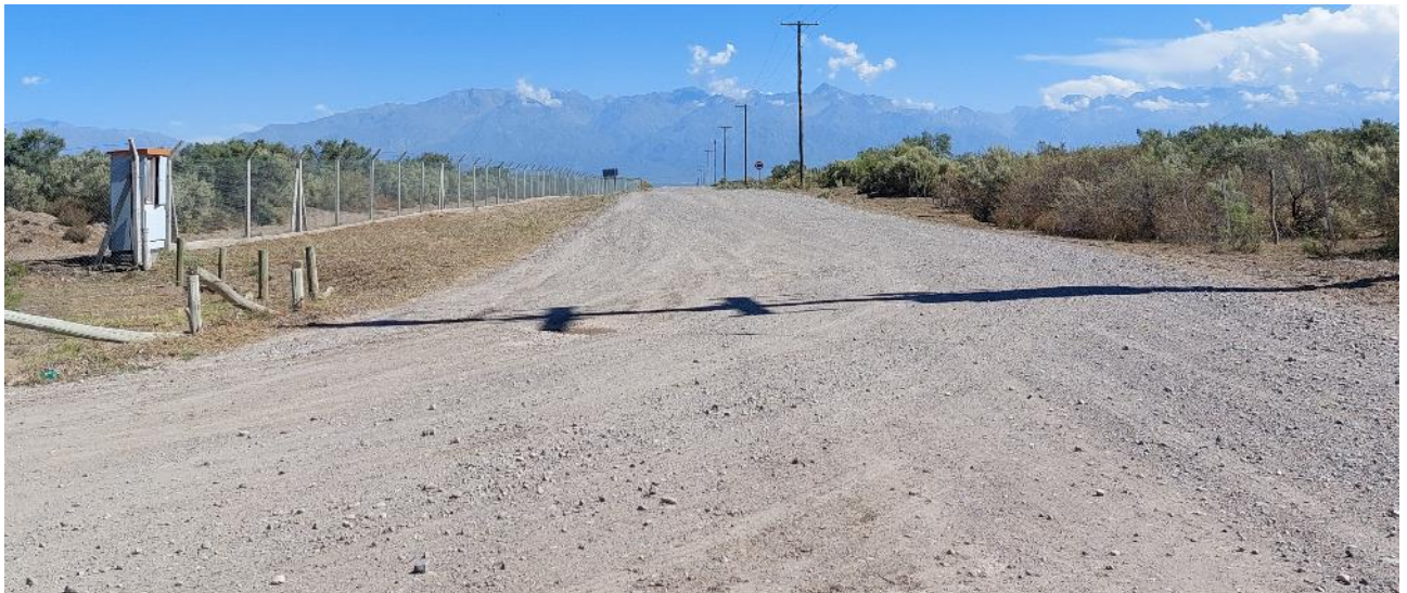
Figura 76: Vista general camino de acceso
