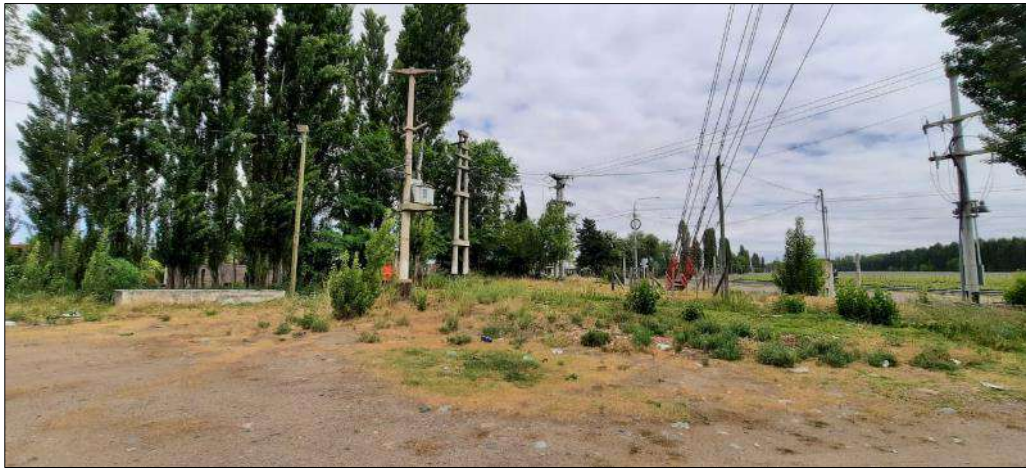
Figura 54: Tillas de anclaje y riendas de antena
