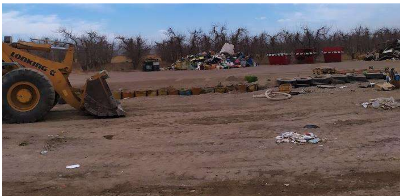
Figura 80: Vista general del predio CAVU-SC
