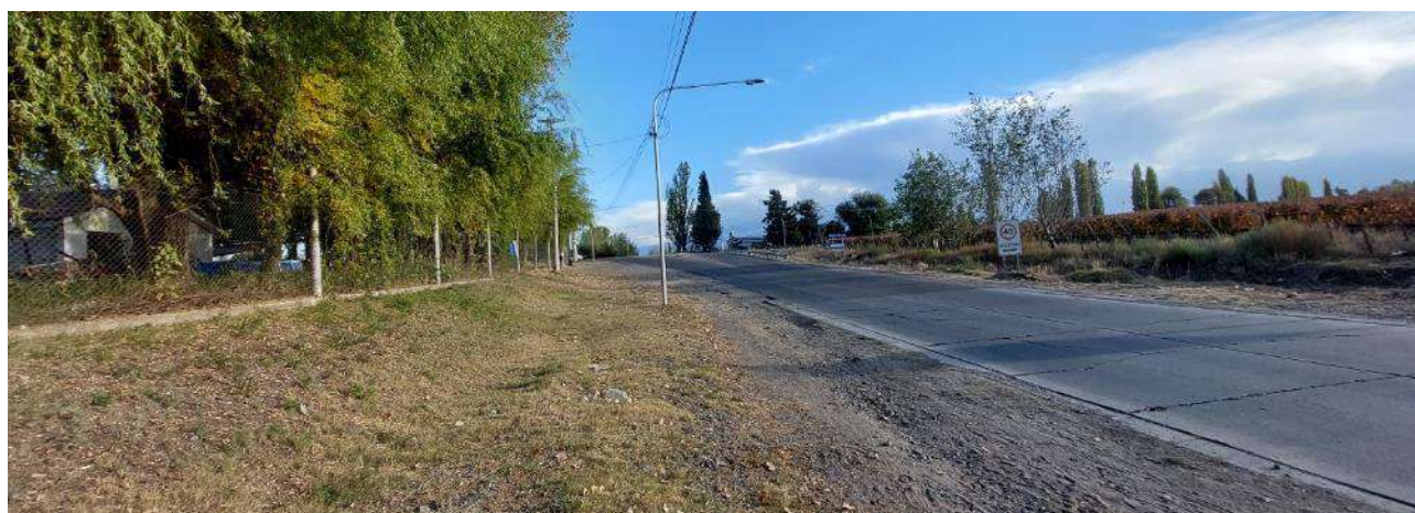
Figura 83: Vista acceso por RP-89
