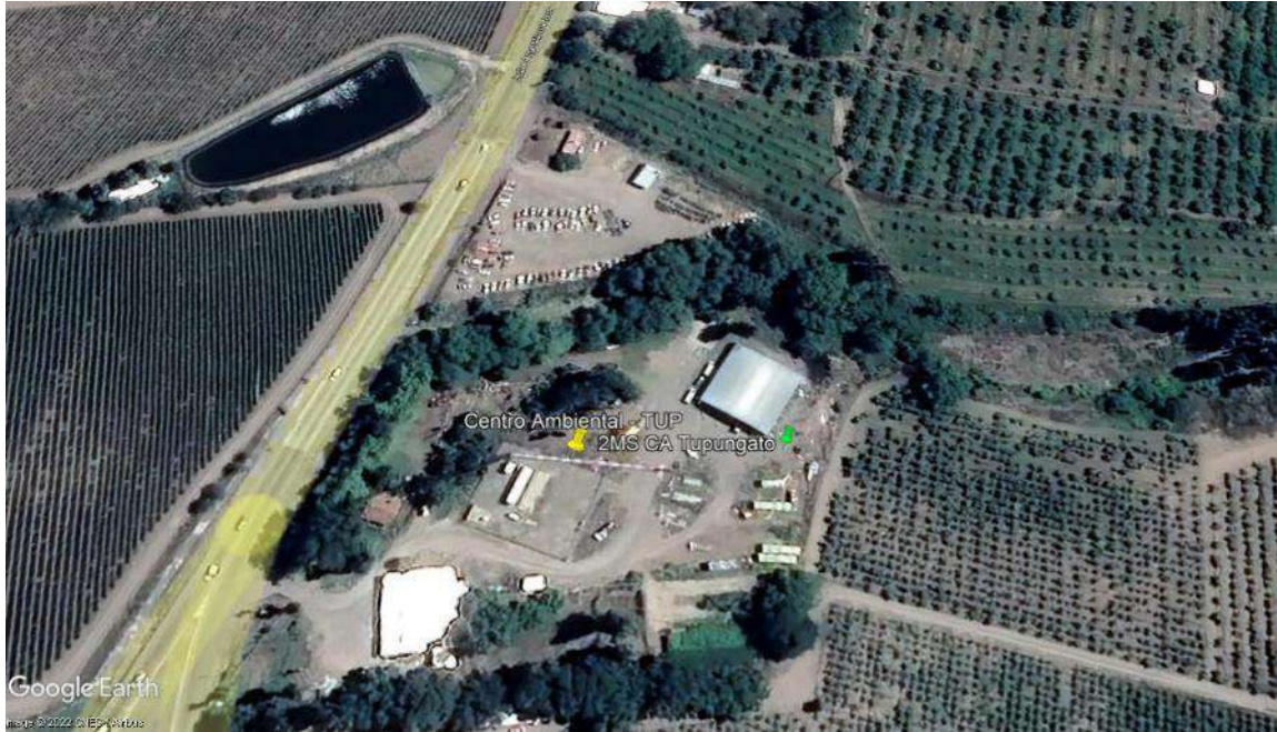
Figura 22: Monitoreo Suelo CA Tupungato
